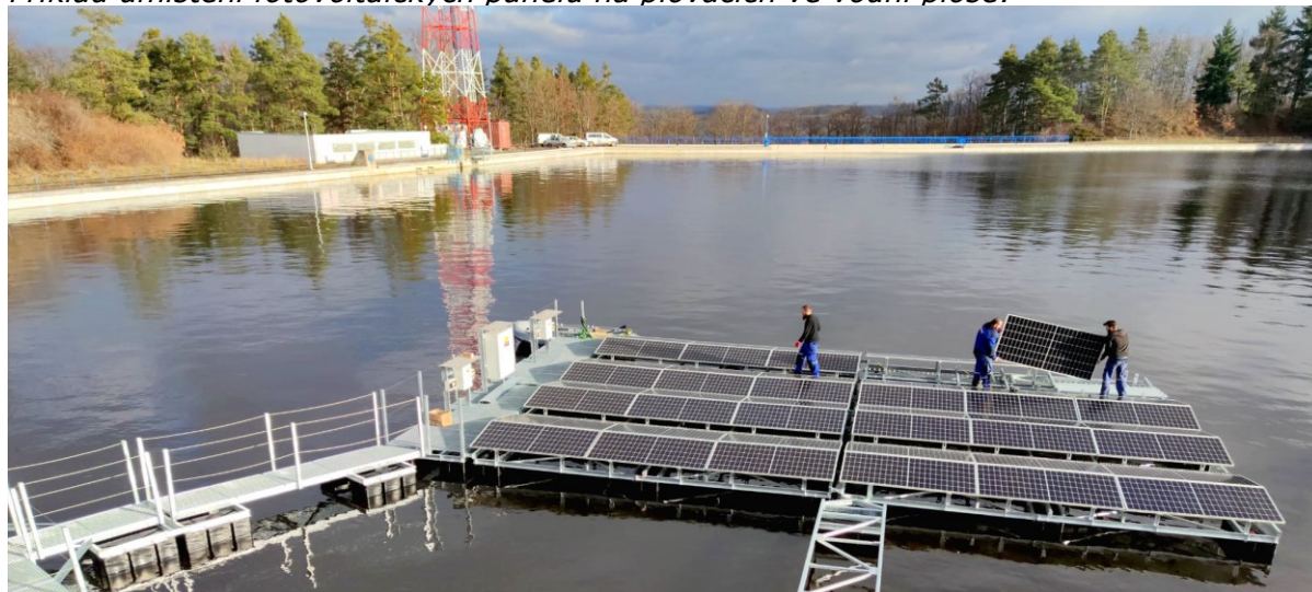
Příklad umístění fotovoltaických panelů na plovácích ve vodní ploše:
