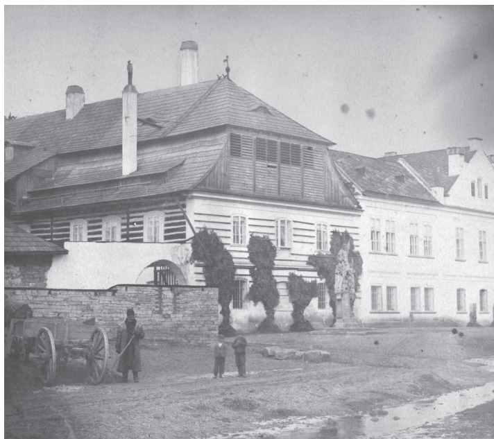
Pohled na Seykorovu továrnu ve II. pol. 19. stol.
