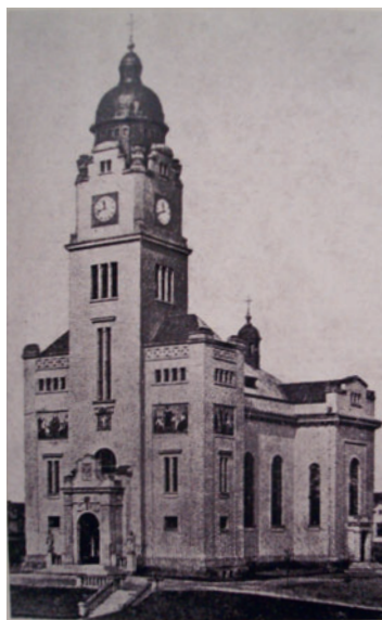
[12] Kostel sv. Václava po dostavbě, pohlednice, 20. léta 20. stol.
