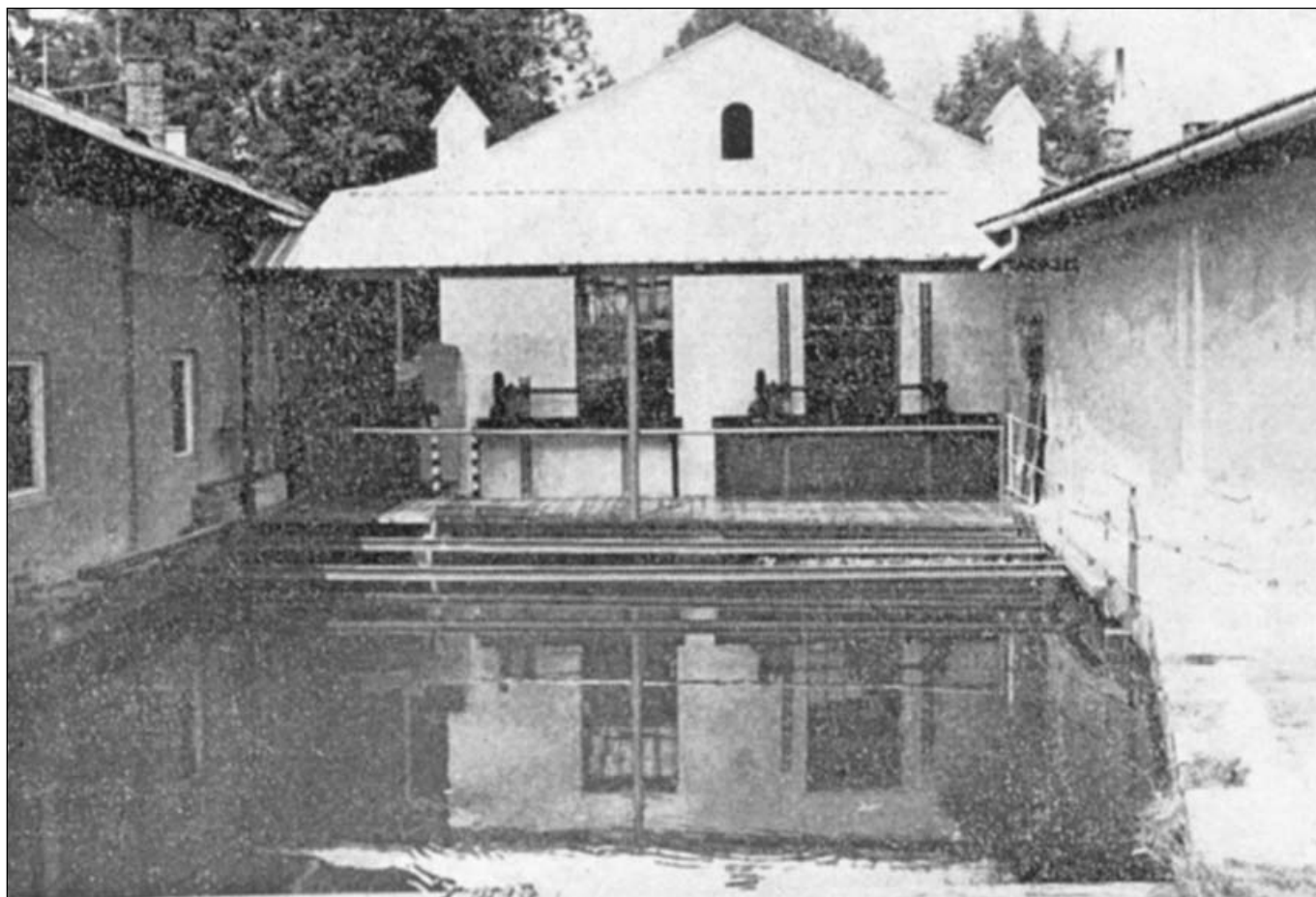
Malá vodní elektrárna v Kostelci nad Orlicí po generální opravě a uvedení do provozu v r. 1988.
