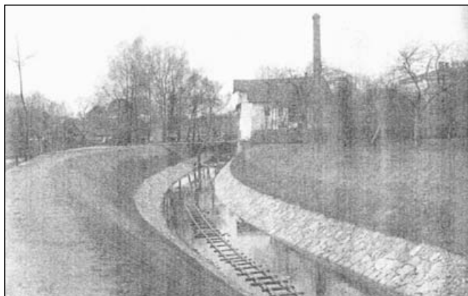
Regulace odtokového úseku náhonu z malé vodní elektrárny, v úseku kolem staré valchy a před vtokem náhonu do Divoké Orlice u skaleckého mostu.
