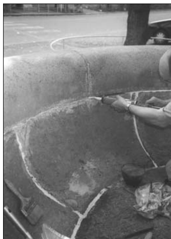
Aplikace polyuretanového tmelu do spár v roce 2001
