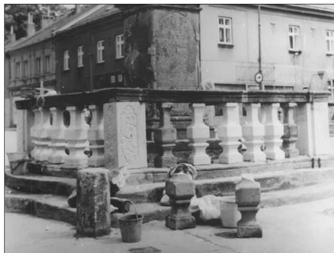
Nově osazené části balustrády Marián. sloupu (r. 1979)
