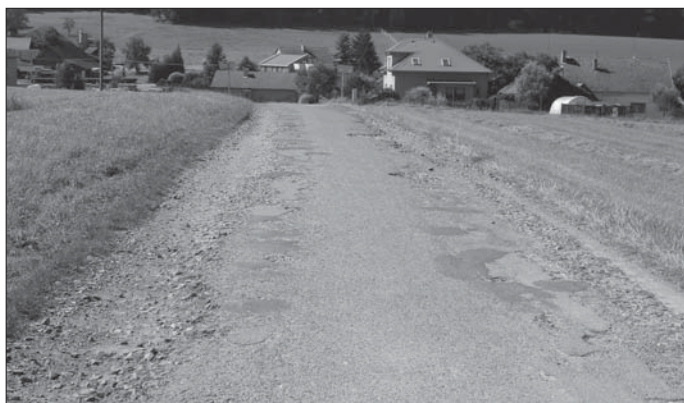
Foto: před opravou
