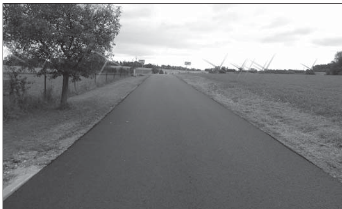
Foto: po opravě
